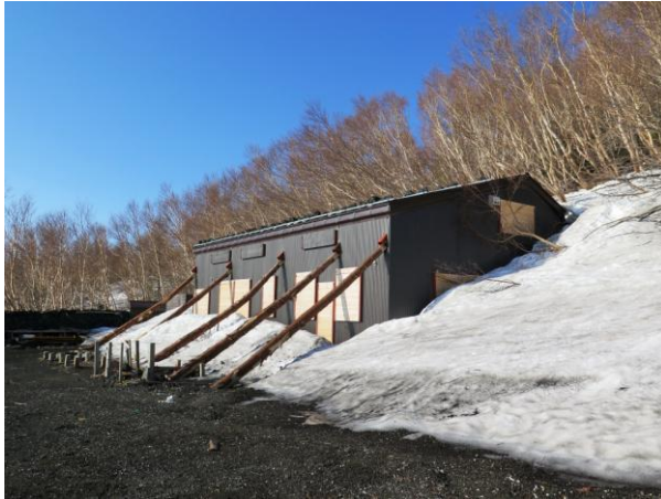
砂払五合目の山小屋は建て替えられていた
